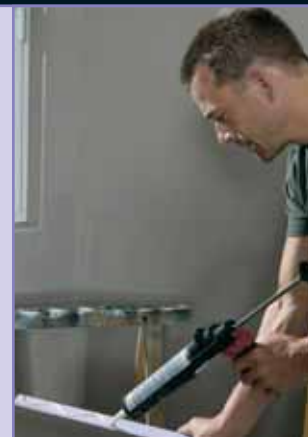
Die JACKOBOARD Bauplatten werden ausgemessen und zugeschnitten. JACKODUR Montagekleber wird auf die Stirnkanten aufgetragen.
