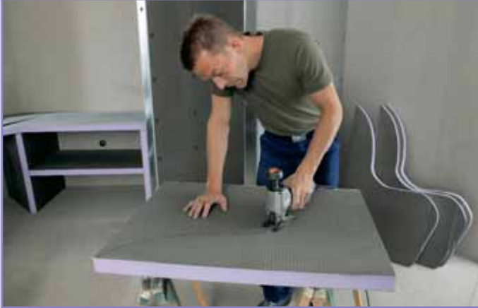
Die Unterkonstruktion der Sitzbank aus 5 cm JACKOBOARD Bauplatte wird mit einer Stichsäge ausgesägt.
