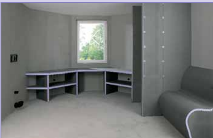
Alle Stoßkanten und sichtbaren Stirnkanten müssen jetzt mit JACKOBOARD Armierband bzw. JACKOBOARD Dichtband armiert werden.
